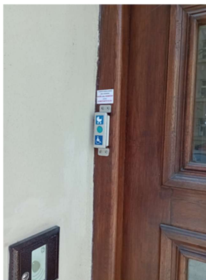
vstup do budovy
